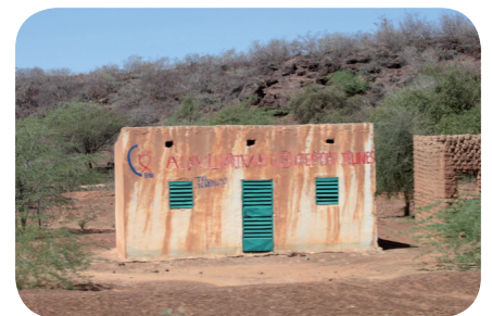
La transformation de l'habitat à Tenkodogo (Burkina Faso - 2012).
